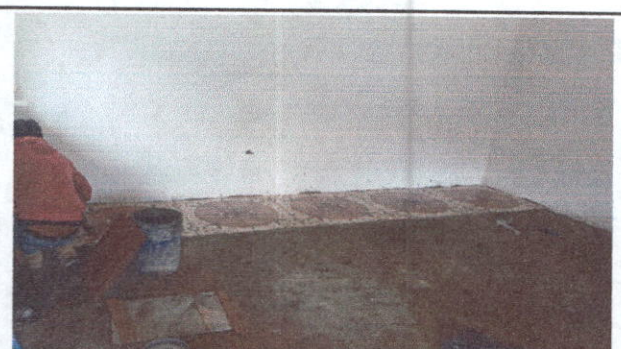
Foto 5: sustitución de piso de torta de concreto
