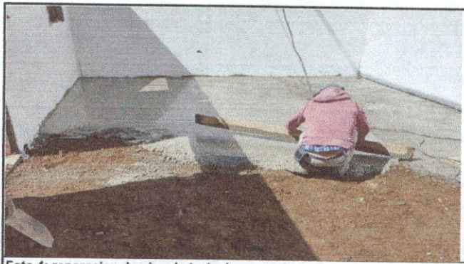
Foto 4: reparacion de piso de torta de concreto
