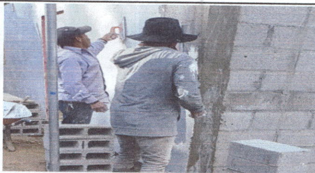
Foto 3: repello de las paredes de la cocina
