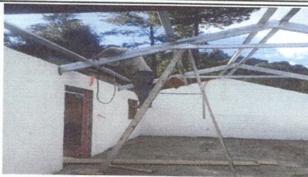
Foto 2: colocando el techo de metal
